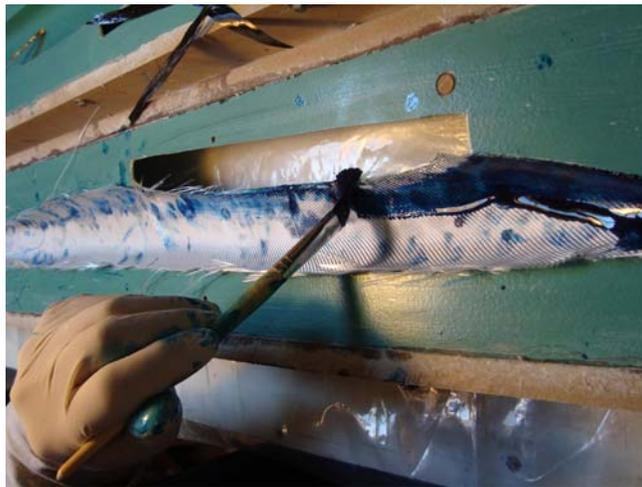
*Pose de la première des 2 couches de 200g/m<sup>2</sup> de fibre et apport de résine pour compléter l'imprégnation.*
